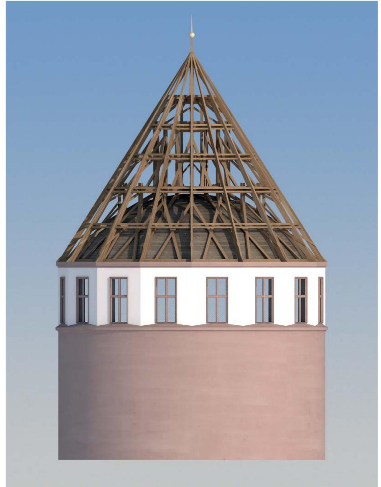
Abb. 385: Dicker Turm, Saal- und Dachtragwerkrekonstruktion nach der Zeichnung des Wetzlarer Skizzenbuches, Ansicht.
